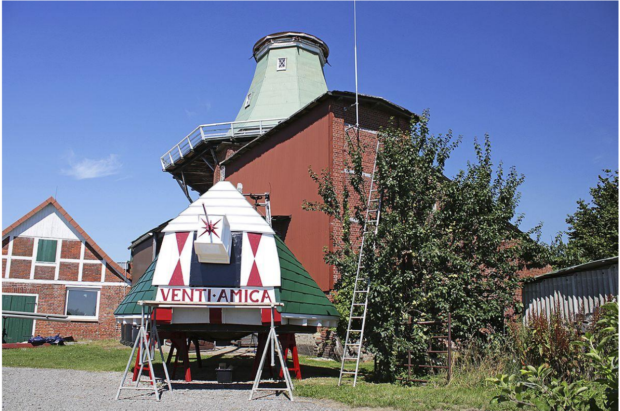
Die neue Dachhaube liegt neben der Mühle schon zur Montage bereit
